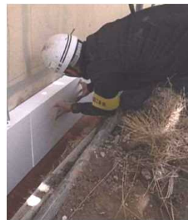
外壁の断熱化工事
