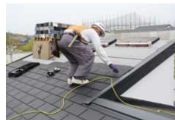
屋根の断熱化工事
